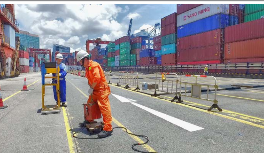
■ 團隊走遍碼頭每寸地方，尋找釋出殘磁的位置，再進行消磁工序
