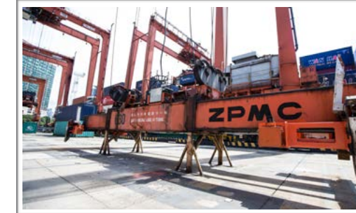
在貨櫃堆場工地上正在安裝Magic Eye及感應器的吊機排架
