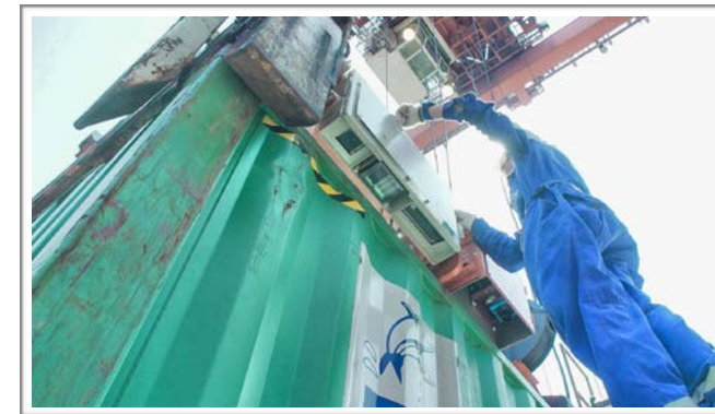
因吊機設計、結構各有不同，排架尺寸也不一樣，安裝好Magic Eye後，工程人員需要逐一調校
